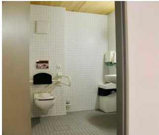
Einsicht Rollstuhlgerechtes WC
